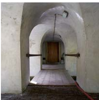
Onder de brug
