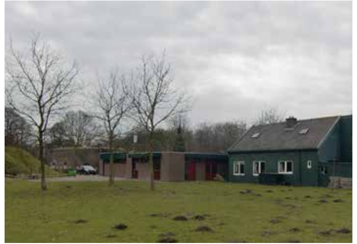
2. Scoutinggebouw en houten woning
